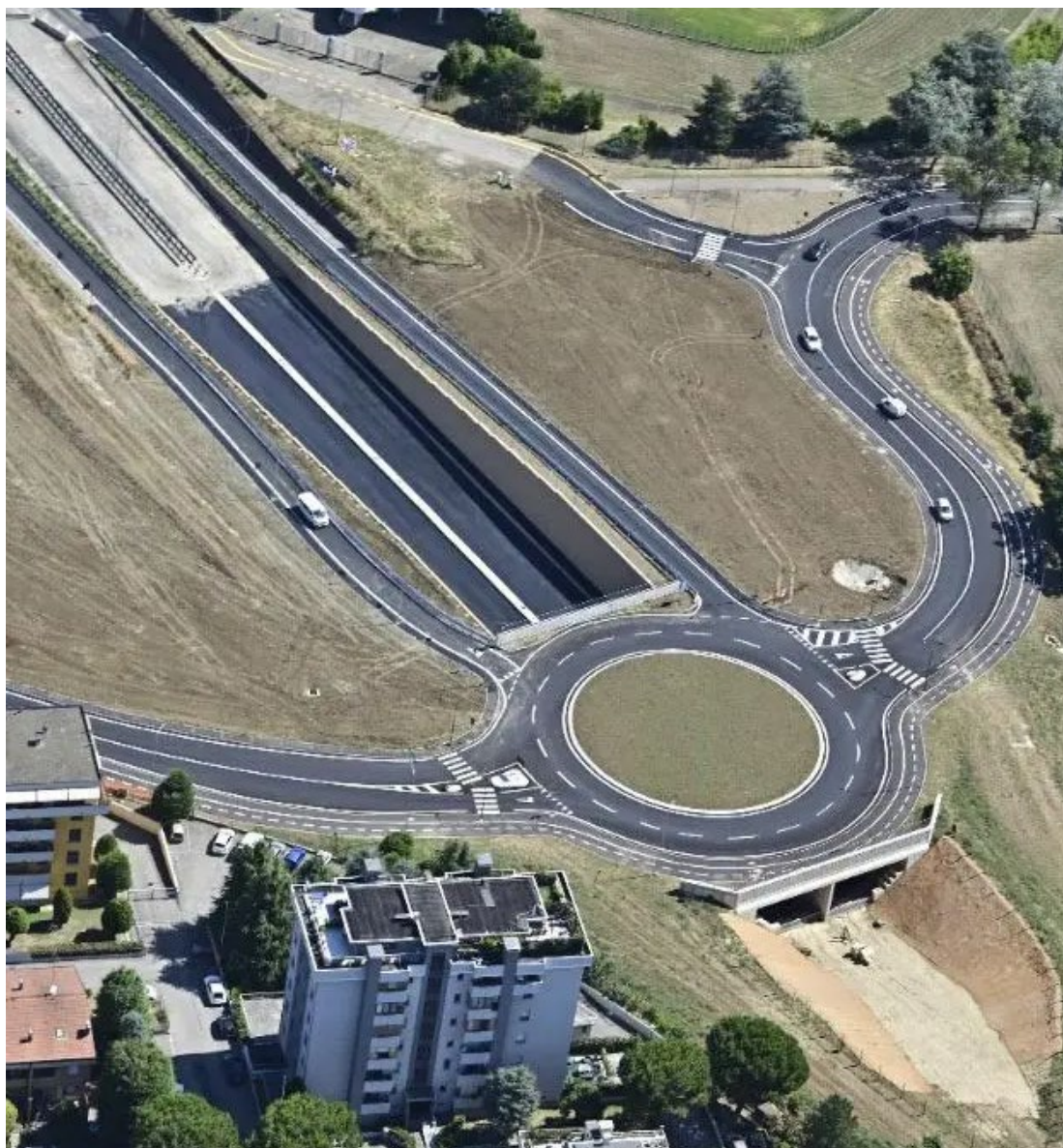
Foto fine lavori
