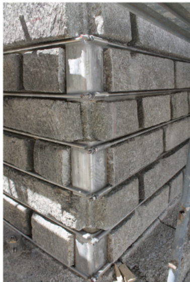
2. Coppie di catene e piastre nello spigolo
