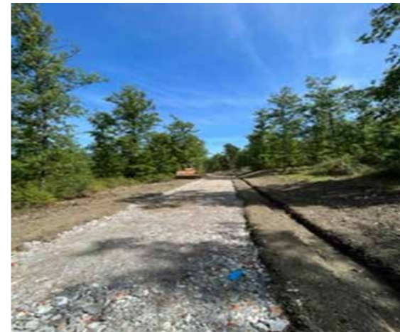
Lavori in corso loc. Valgoni
