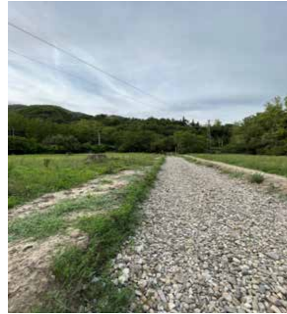
Lavori in corso Sibano
