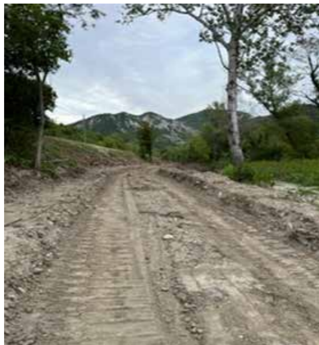
Lavori in corso Pioppe di Salvaro
