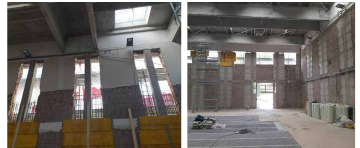
Nuovi pilastri opportunamente armati a ridosso di quelli esistenti
